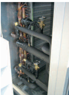
Fig. a - Valvole di espansione termostatica Thermostatic expansion valve
