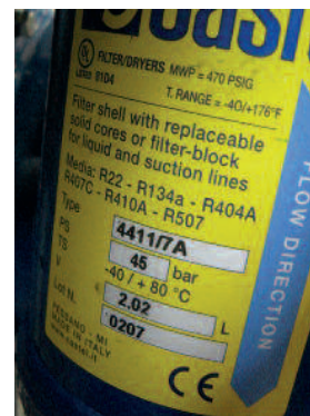
Fig. c - Filtro deidratatore Dryer filter
