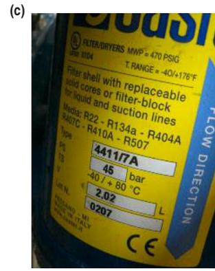
Valvole di espansione termostatica (a); valvola di inversione a 4 vie (b); filtro deidratatore (c).
