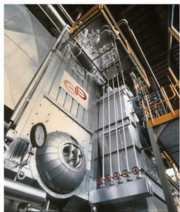
di manutenzione, anche nei casi di impieghi più gravosi. I generatori della serie ERTA sono forniti attraverso gruppo ATR di Castelfranco veneto TV, completi di impianto di combustione e di un sistema di controllo, regolazione e registrazione dei parametri di processo, gestito da un PLC interfacciato con un personal computer.
