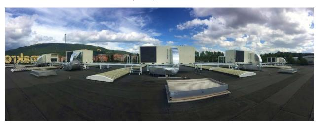
Il sistema di recupero termodinamico di **KUBIC rooftop series** permette di utilizzare, fino in fondo, ogni piccola risorsa termica ancora disponibile: l'aria in espulsione è filtrata e inviata nelle batterie di evaporazione invernale o di condensazione estiva, riducendo, così, i consumi di energia e amplificando il campo funzionale di temperature dell'ambiente esterna.
