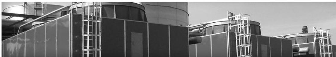
La differenza tra la temperatura dell'acqua fredda prodotta e la temperatura dell'aria a bulbo umido (approccio), è significativa per determinare la dimensione della torre evaporativa. Minore è il differenziale tra le due temperature, maggiore sarà la superficie di scambio necessaria. Il differenziale non dovrebbe essere mai inferiore a 3K o 4K.
