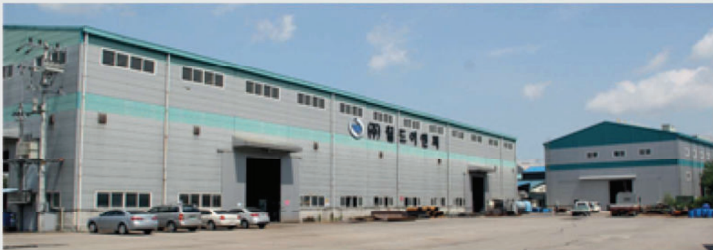
foto esterna stabilimento
