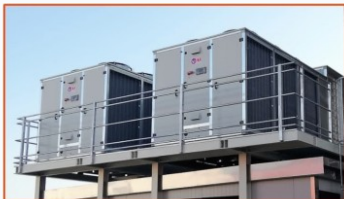
Unità rooftop ETH.M di E.T. e dispositivo ionizzatore Bioxigen®
